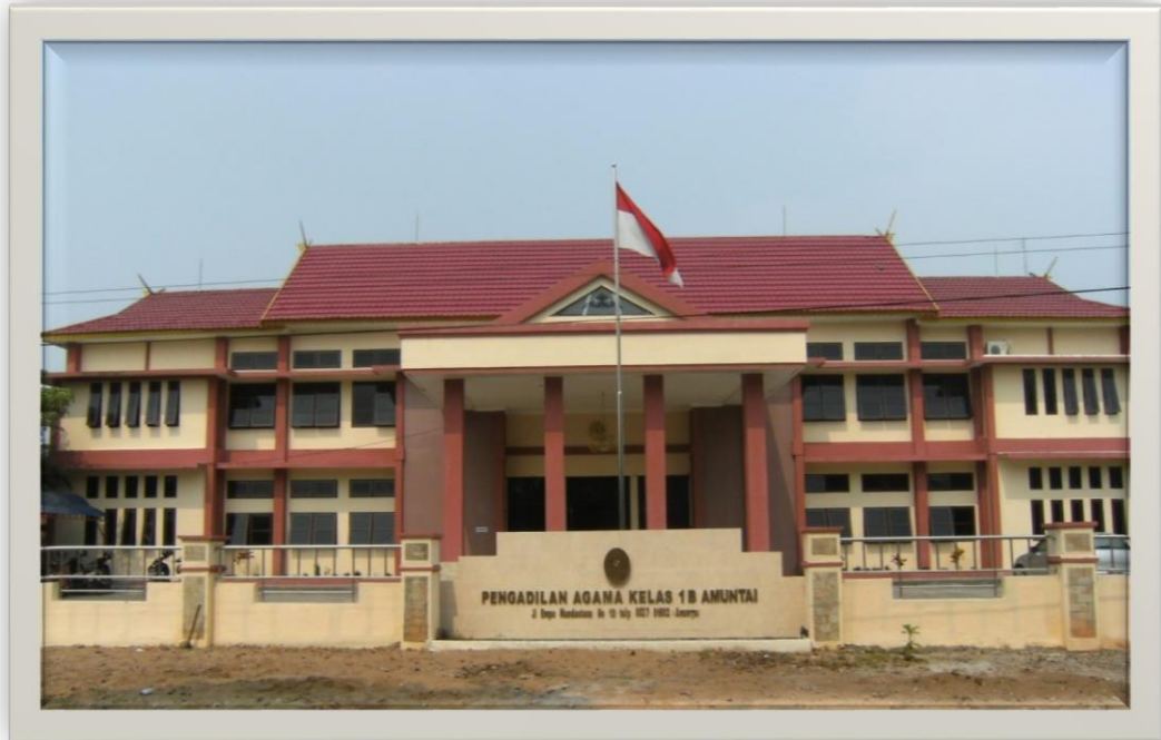
Gambar 1. Gedung Kantor Pengadilan Agama Amuntai Kelas IB
